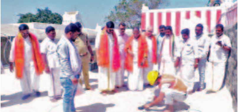
ఆలయం పైభాగంలో లీకేజీల అరెస్టు పనులను చేపట్టిన పూజే నిపుణులు
